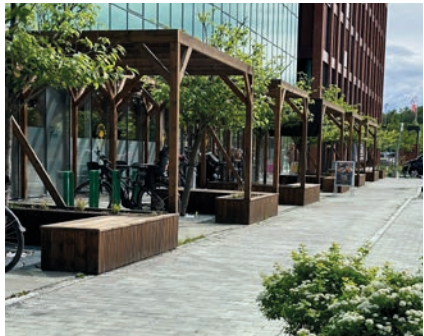
Eksisterende kantsone med arkade/ pergola, møblering og beplantning mot forretning og tjenesteyting i Sluppenvegen 25. (Foto: Sluppen, Trondheim)
